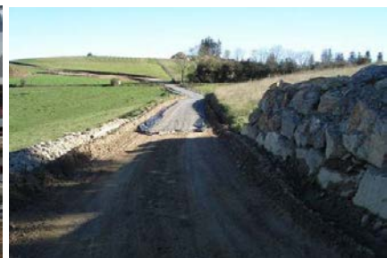
Mise en place du gravier
