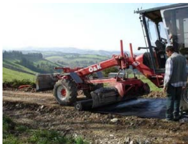
Pose du géotextile
